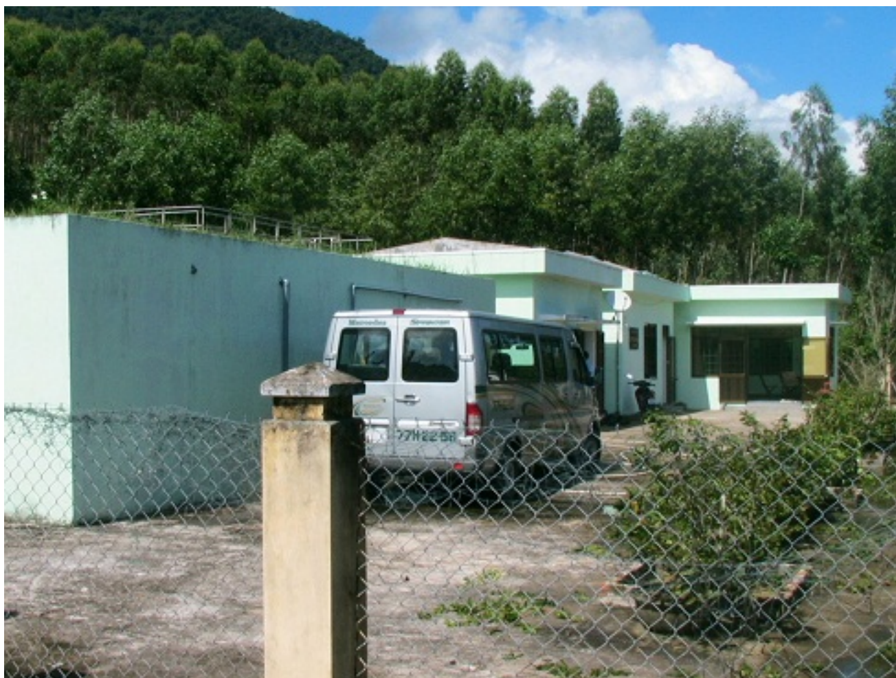
Hình ảnh nhà máy Nước sạch Bình Thuận
